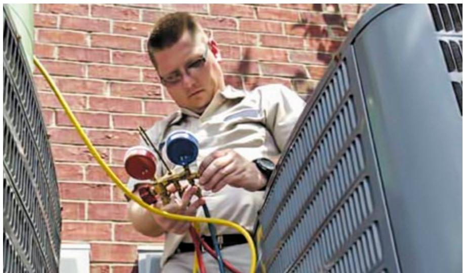
**Рисунок 5: Заправка системы кондиционирования воздуха ГХФУ-22**
