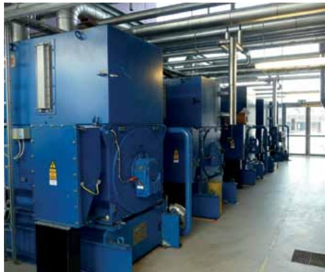
Общий вид высокотемпературной аммиачной системы с винтовым компрессором (централизованная система), установленная в городе Драммен.
