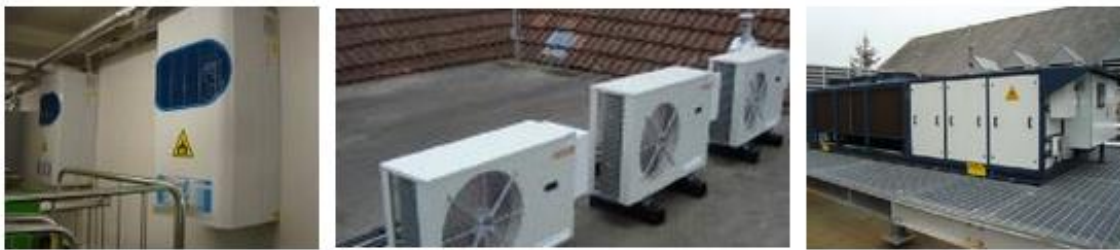
Примеры оборудования на углеводородах
