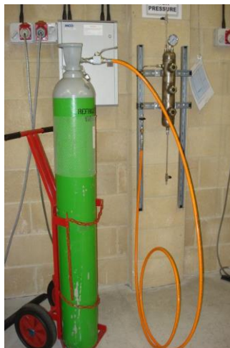
Рисунок 5.11. Баллон, подключенный к оборудованию для заправки
