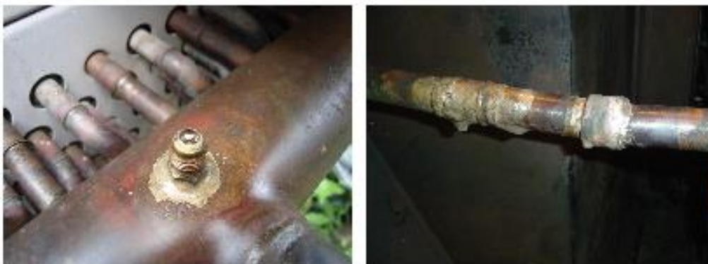
Примеры визуальных индикаторов утечек
